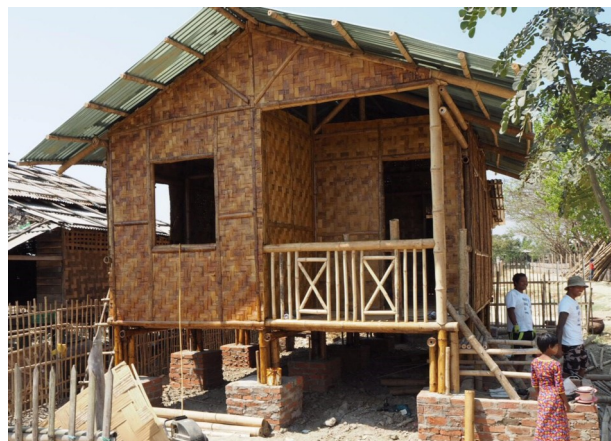
伝統的な素材を生かしつつ、土台や屋根を強化された家。
