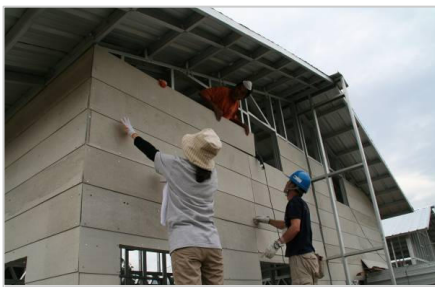
建築が容易なスチールフレーム住宅の骨格と外壁
