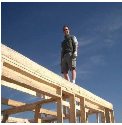
家枠作り(青山学院大学GVチーム) House Frame Making (Aoyama Gakuin Uni. GV Team)
