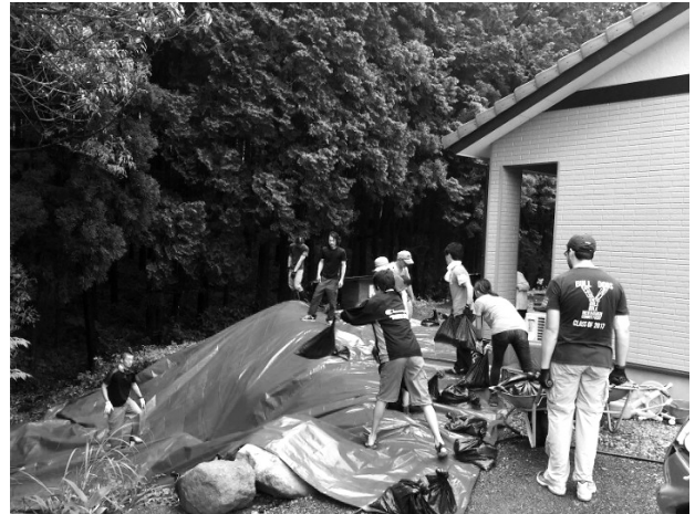
写真-7 崩れた斜面にブルーシートをかけ雨水による侵食を防ぐ
