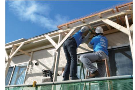
岩手県大船渡市の大豆沢仮設では、ベランダ側の窓にひさしがなく、雨の時は洗濯物や屋外で保管する備品がびしょ濡れになっていたため、ひさしを製作、設置しました。
