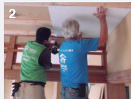
建物内部が乾いたら、窓の交換を実施。その後、壁・床・天井の張り直しや塗装、外壁の洗浄などを行いました。同時に、業者による電気工事・水道工事も進められました。
