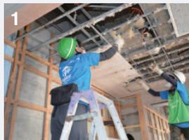
建物内部の解体作業からとりかかり、浸水により傷んだ床・壁・天井のボードを手作業で撤去。再利用できる木枠などは塩素漂白剤を使って消毒を行い、カビを防止しました。
