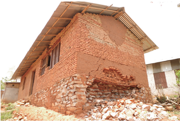
写真-9 倒壊を免れた日干しレンガ造の壁面 (パナウティ市)
