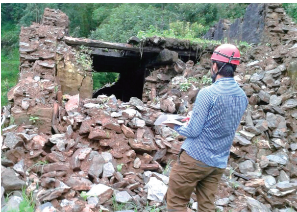
写真-8 跡形もなく瓦解した石造・泥接着の組積造 (ジリ市)
