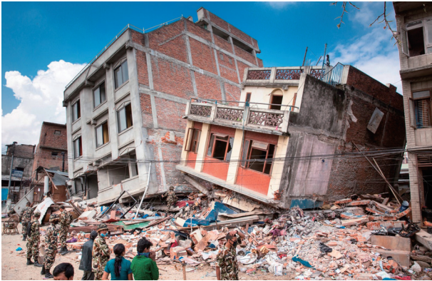
写真-7 地震で下の階が完全に押しつぶされた住宅
