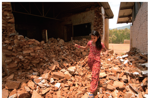
写真-2 地震で完全に瓦解したレンガ造の組積造住宅
