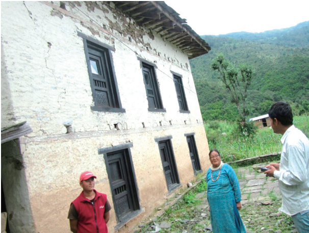
写真-3 崩壊は免れたがひび割れが散見される石造住宅（ジリ市）
