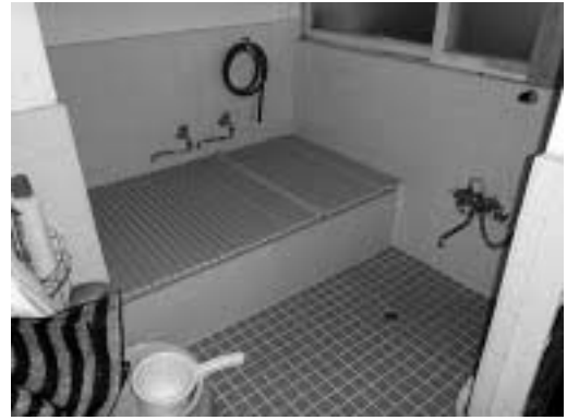
写真－6-2 地震で被災した世帯。浴室のタイル補修を支援した (⇒ After)
