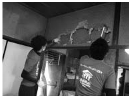
写真-10 内壁の補修。事業後半、簡易補修はボランティアでも可能に
