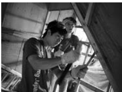
写真-2 泥出しや壁剥がし等の作業は震災後1年で390軒を超えた
