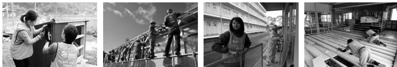
写真-14 仮設住宅の物置やひさしの製作、網戸の設置、公民館の修繕
