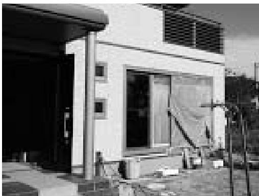
写真-5-1 津波で被災した世帯。サッシの入替えを支援した (Before ⇒)
