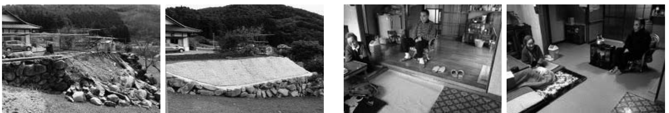
地震で崩れた石垣の補修（宅地の崩落防止）、地震で歪んだ床の補修（バリアフリー工事）
