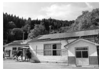
写真-13 大きなメンテナンスの必要もなく、20年以上にわたって安定的な収入を見込める点は大きい。
