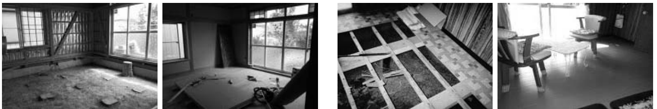
床板の張替え
