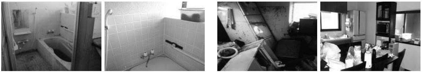
浴室、キッチンの補修
