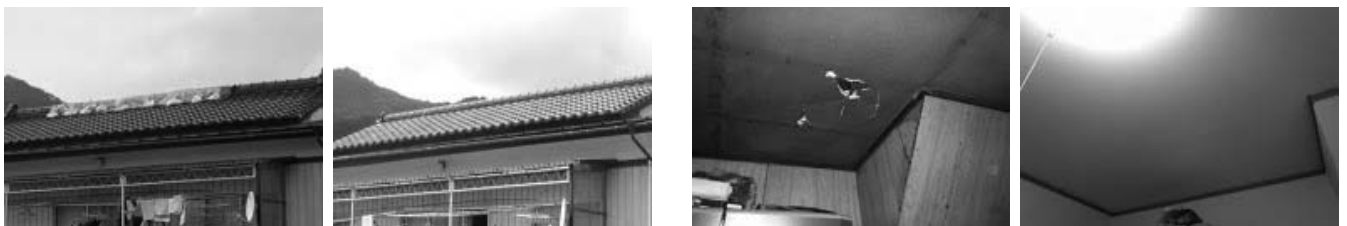
屋根、天井の補修（雨漏り対応）
