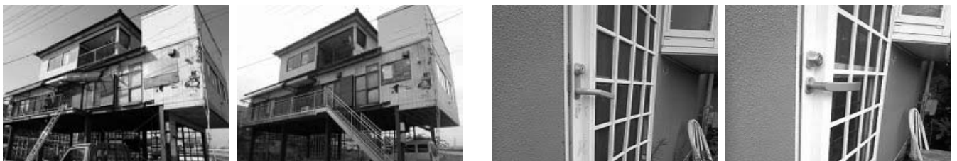
津波で流された階段通路の設置、地震で施錠不可となったドアの補修
