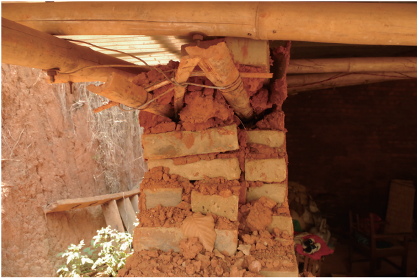
写真-5 泥土のみで仕上げたレンガ造の壁面
